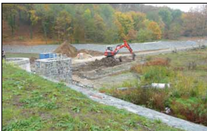
Odstraňování zeminy před hrází
