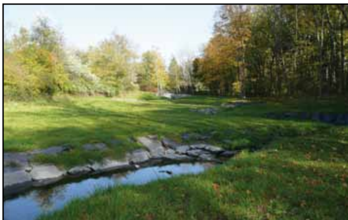
Přítok vody do poldru
