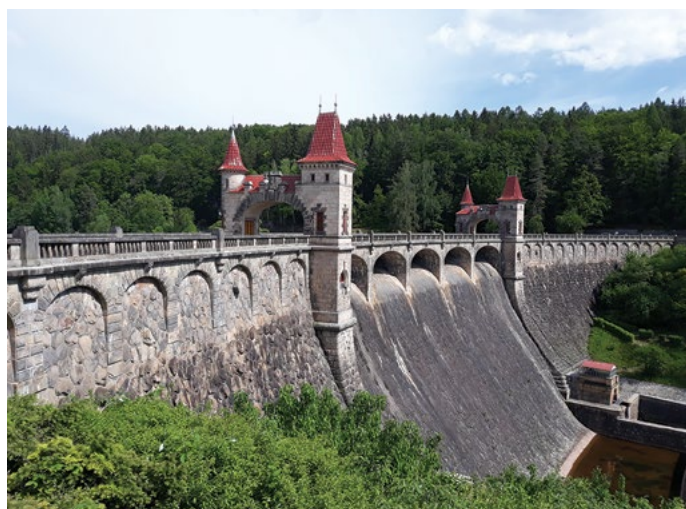
Hráz přehrady po rekonstrukci průjezdových bran
